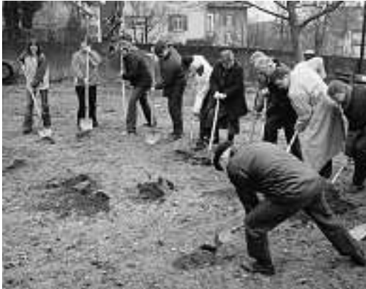
Am 12. Januar 2004 erfolgte der Spatenstich.
