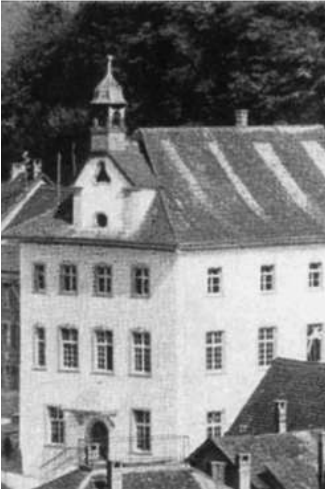
Am 1. Juli 1923 konnte ein Gottesdienstraum eingeweiht werden, der durch das grosszügige Entgegenkommen der Ortsbürgergemeinde Laufenburg im Parterresaal des Gerichtsgebäudes eingerichtet werden konnte.
